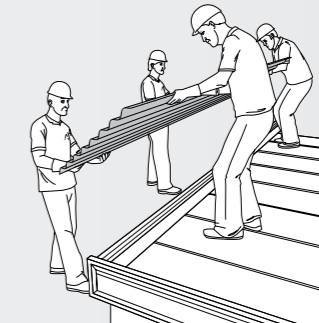
Utilizar o mesmo número de pessoas em cima e embaixo do caminhão.
