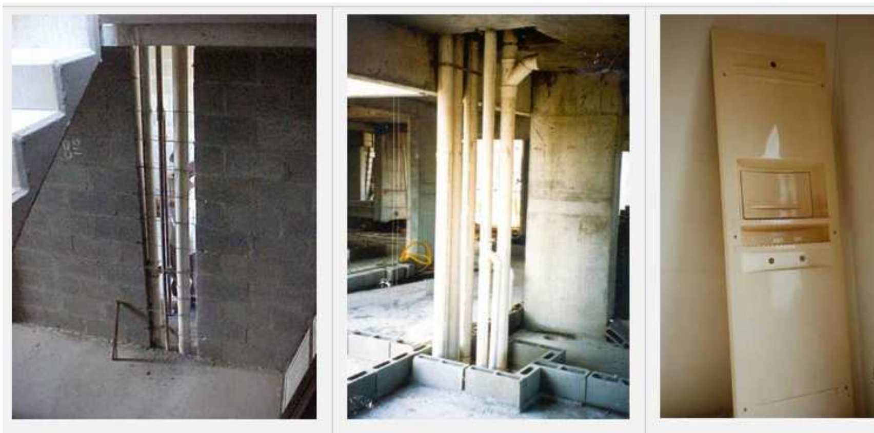
Exemplos de shafts interno e externo e carenagem plástica para fechamento de shaft
