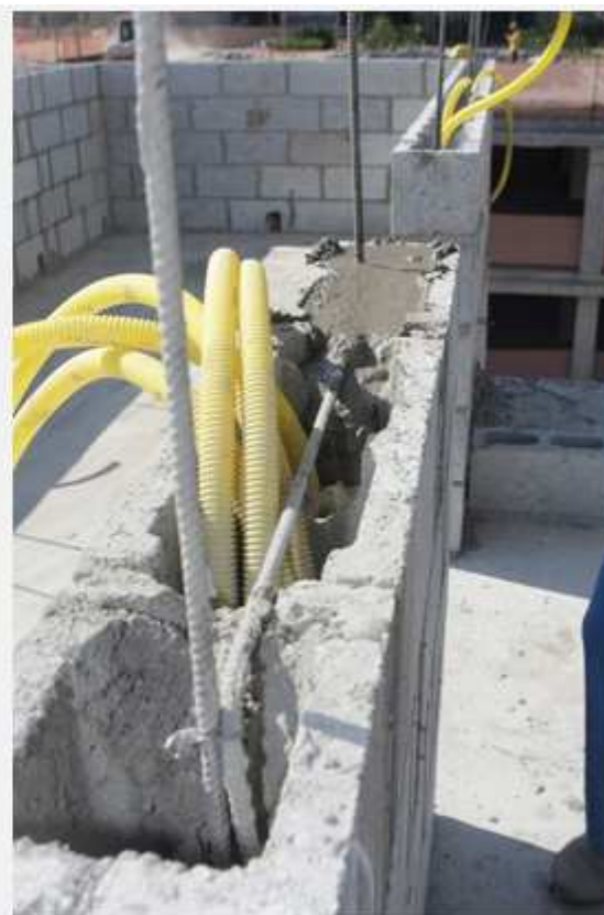
de eletrodutos pela parede
