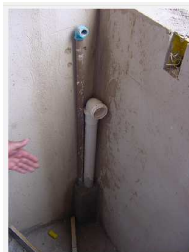
Tubulação hidráulica e sanitária aparente ou embutida em blocos especiais (paredes não estruturais)
