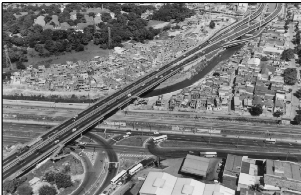
Figura 19 – Interseção com sinalização semafórica
