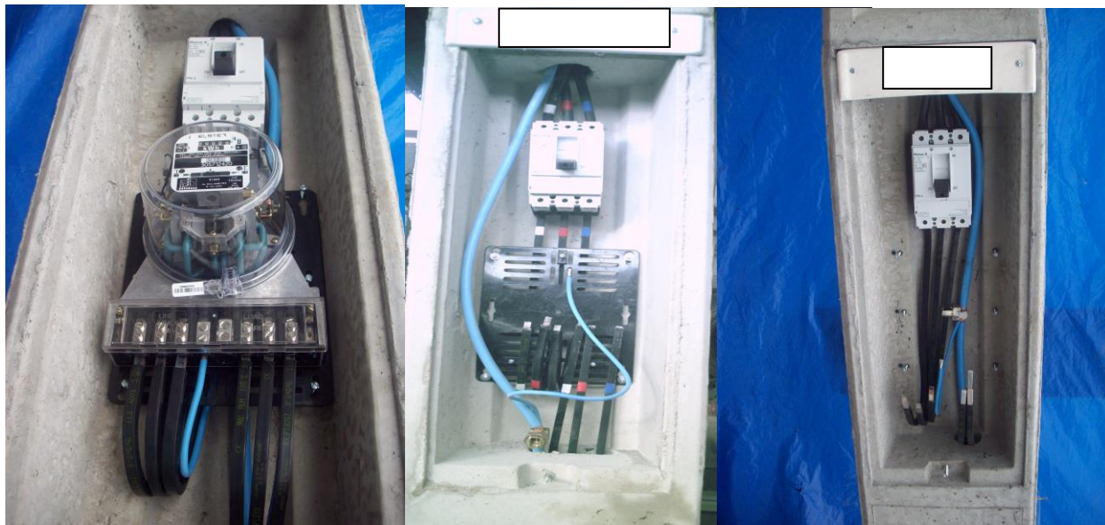
Des. 26 – Ilustração do detalhe do aterramento e do barramento flexível isolado.
