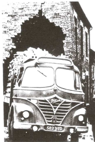
Figura 3.11 Efeito arco em parede após ação accidental (cortesia Clayford T. Grimm).
