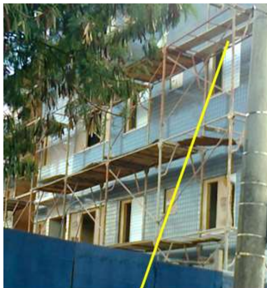
Andaime fachadeiro sem proteção contra queda de altura do tipo guarda corpo e rodapé e com forração incompleta do piso
