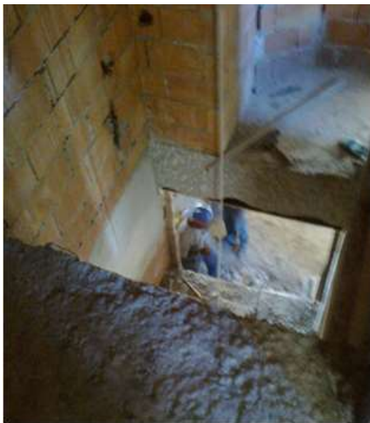
Caixa do elevador sem fechamento provisório contra queda de altura
