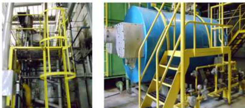
Meios de acesso às caldeiras: (i) à esquerda, escada fixa vertical; (ii) à direita, escada de degraus sem espelho. Detalhe para os guarda corpos vazados.
