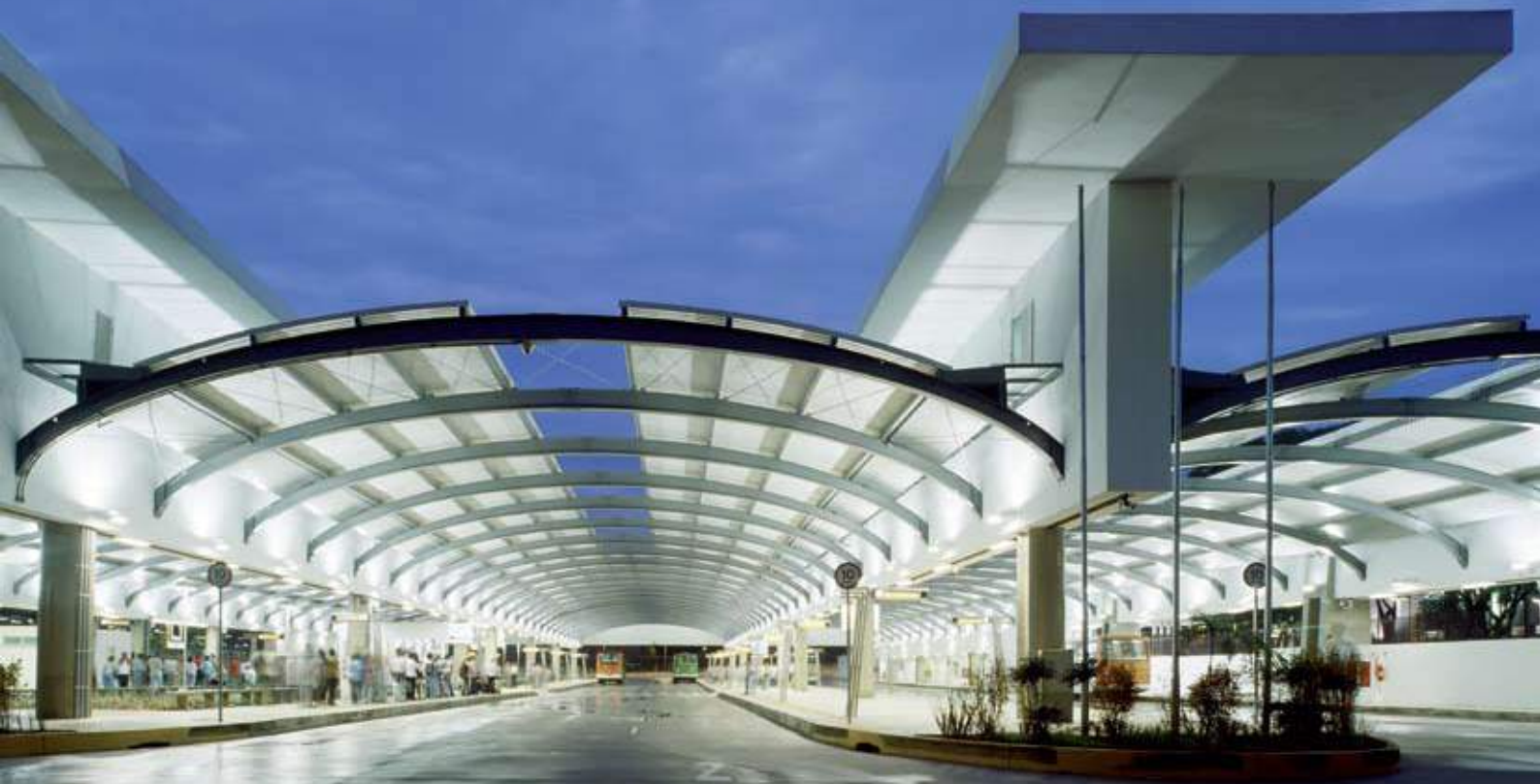
Cobertura Terminal da Lapa (SP) Foto: Nelson Kon
