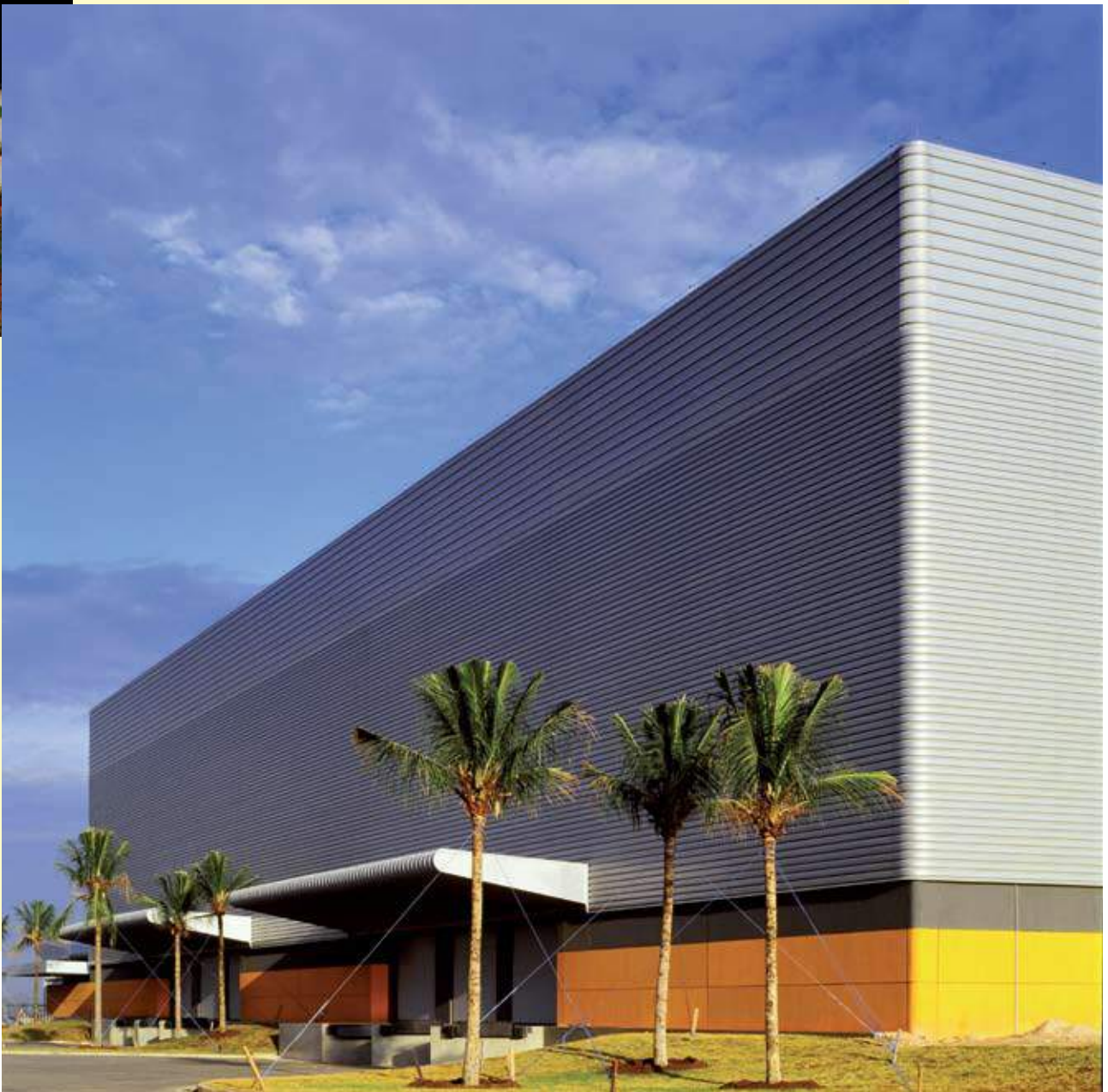
Cobertura e fechamento com telhas de aço - Entrepósito Alfandegário EADI Foto: Nelson Kon
