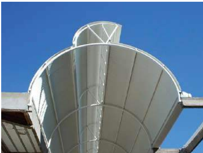
Passarela com telhas onduladas calandradas LR 17
