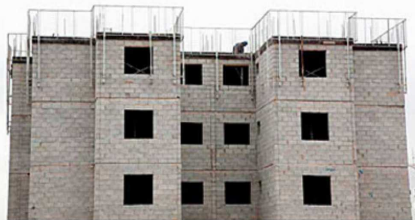
Foto 46: O trabalho dos pedreiros no andar é precedido sempre da colocação de uma proteção na periferia do edifício para segurança contra quedas.
