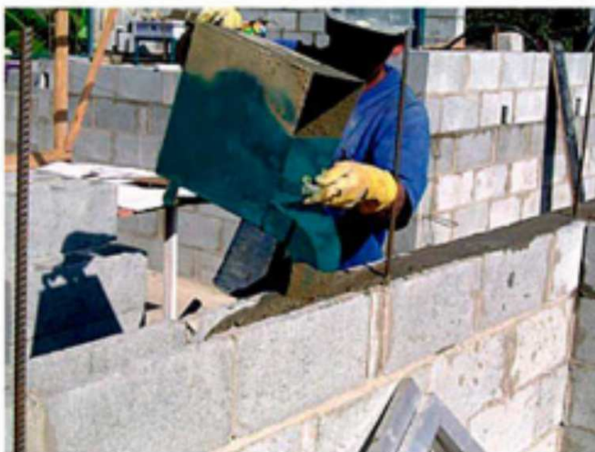
Foto 5: Balde especial para lançamento de graute.
