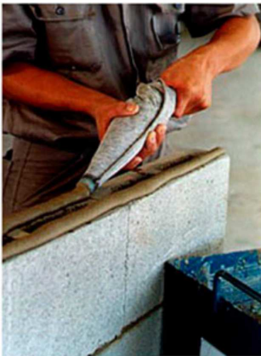
Foto 2: Bistaga para aplicação de argamassa de assentamento
