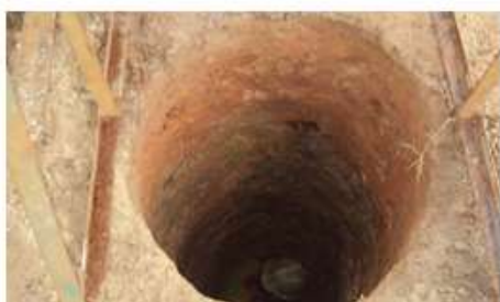
Tubulação a céu aberto (Construção civil)
