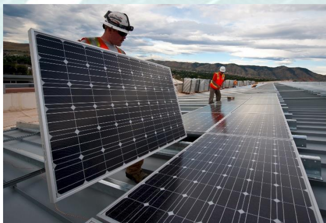
Figura 1 – Instalação padrão de painéis mono-cristalinos em galpão – Fonte: Pixabay ( www.pixabay.com )
